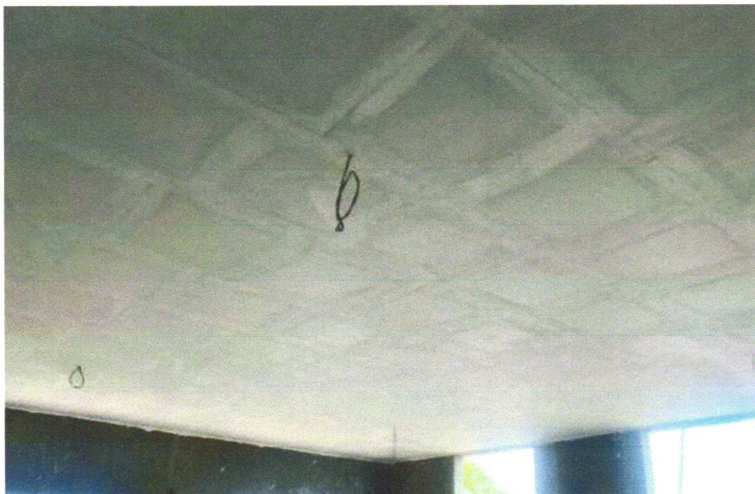
EXECUÇÃO DE FORRO DE GESSO.
