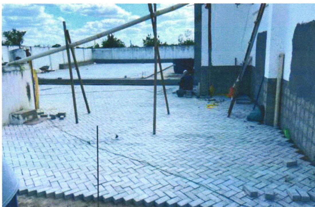
EXECUÇÃO DE PISO INTERTRAVADO.
