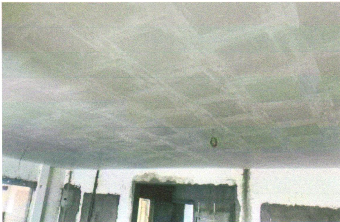
EXECUÇÃO DE FORRO DE GESSO.
