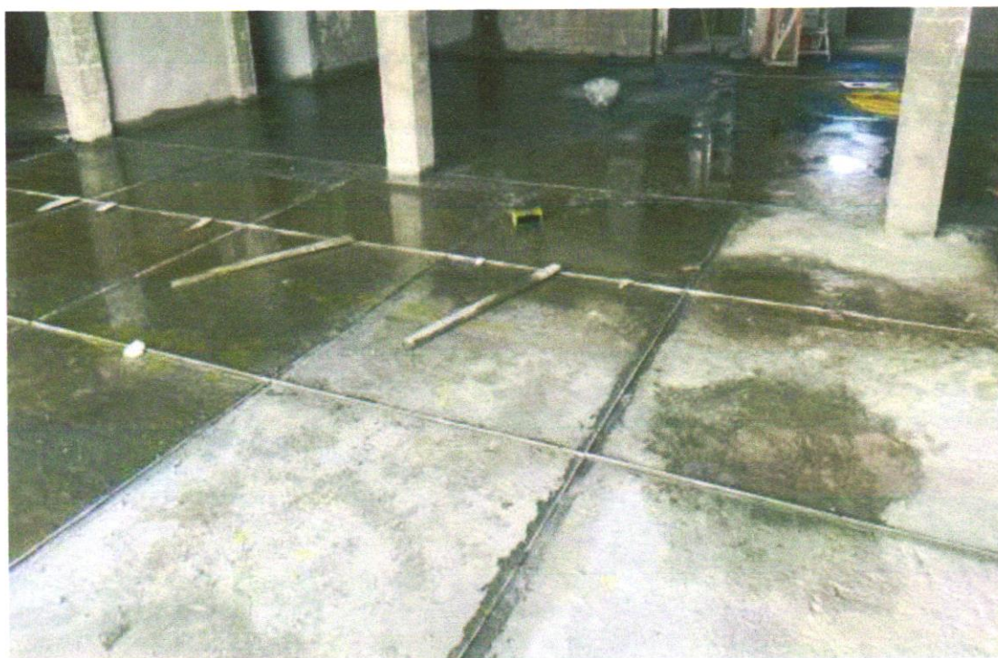
EXECUÇÃO DE PISO GRANILITE.
