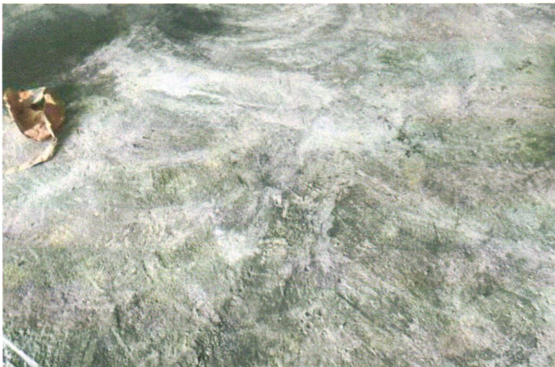
EXECUÇÃO DE PISO GRANILITE.
