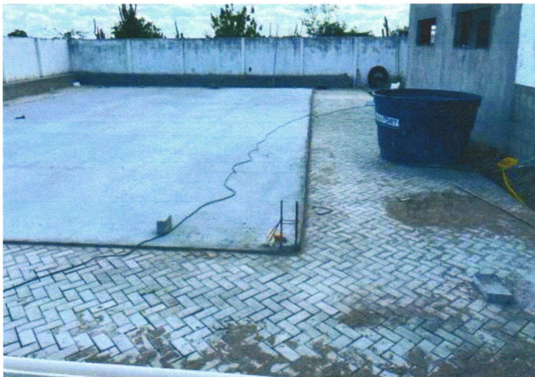
EXECUÇÃO DE PISO INTERTRAVADO.
